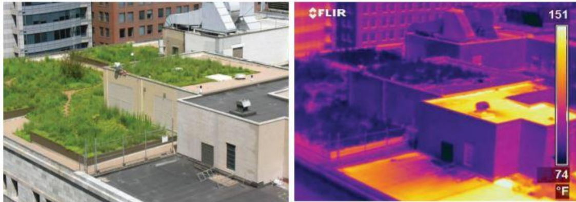
FIGURA 2. La terraza verde del City Hall de Chicago muestra una diferencia de 40° C respecto a los materiales convencionales. FUENTE: Environmental Protection Agency, (2009).
